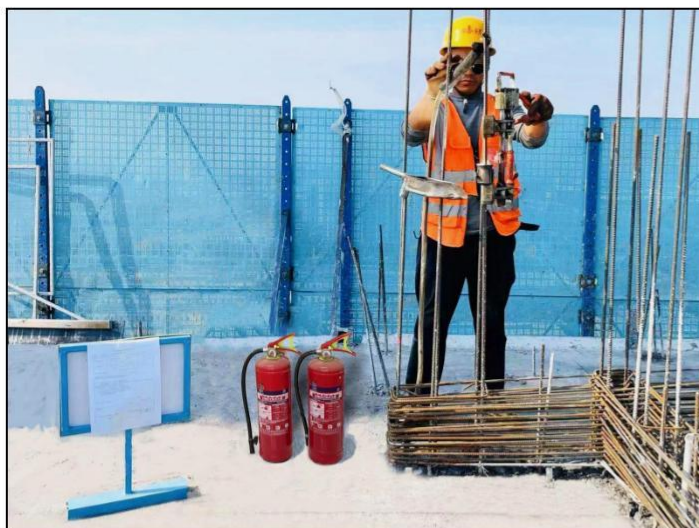
钢筋动火作业
