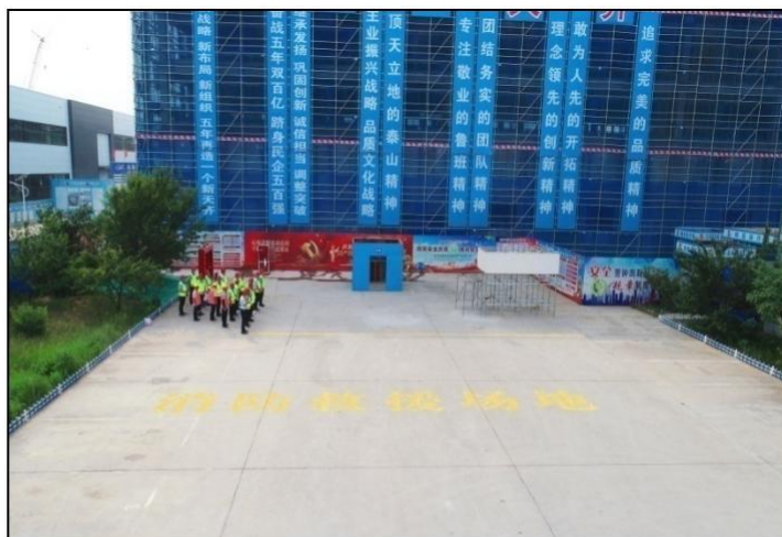
施工现场救援场地
