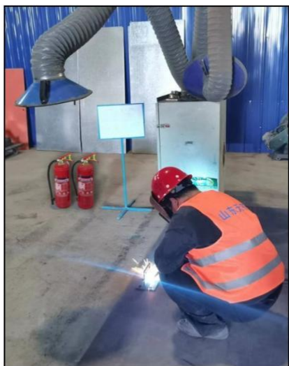
电焊动火作业
