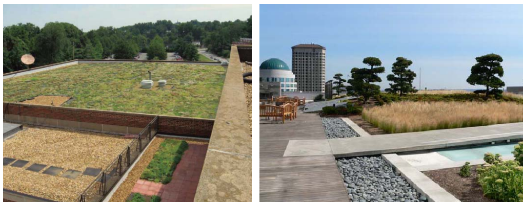
图 6-12 简单式种植屋面、花园式种植屋面
