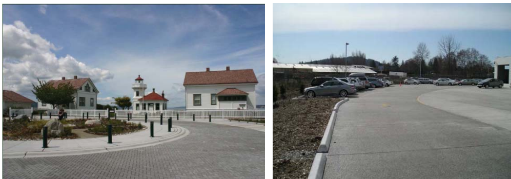
图 6-9 透水铺装和透水路面
